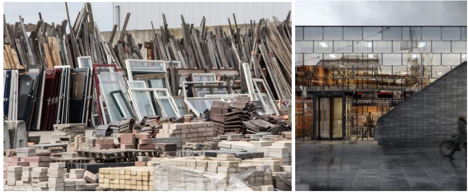
Figuur 20: Hoogwaardig hergebruikte objecten (bouwdelen) 65 en toepassing bij de NS-fietsenstalling in Eindhoven 66
