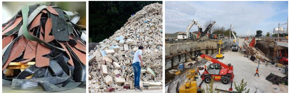
Figuur 21: Secundaire grondstoffen (bitumen, keramisch afval en beton) voor dakbedekking, metselwerk en beton bij Spoorwegviaduct Contactweg in Amsterdam 67
