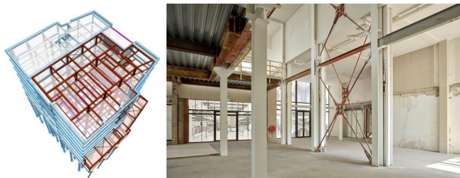
Figuur 29: Hergebruikte staalconstructie Hoogstraat 168-172, Rotterdam 76
